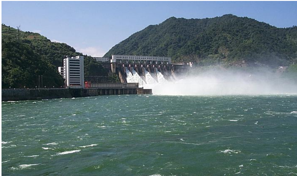
柘溪水库泄洪
