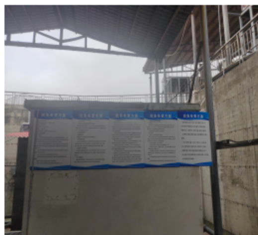
污水处理站应急处理措施制度上墙
