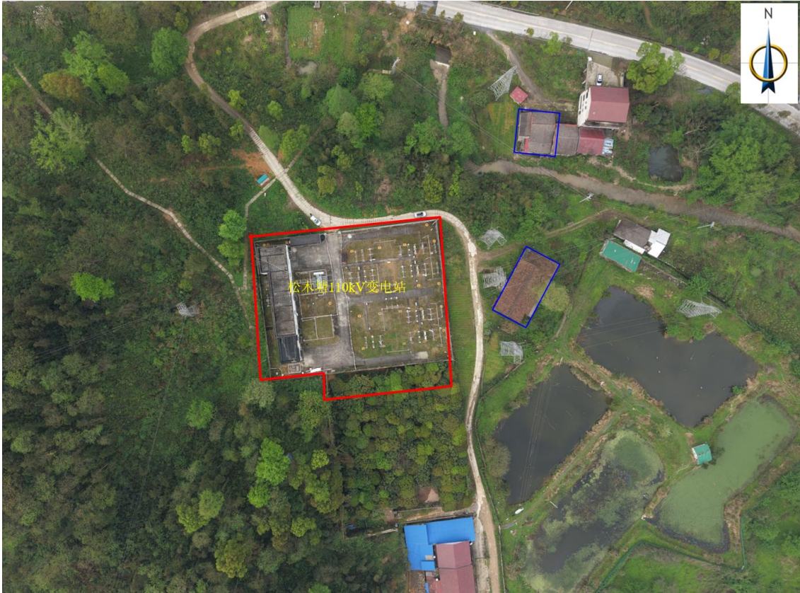
图 3-7 松木塘 110kV 变电站周围环境现状
