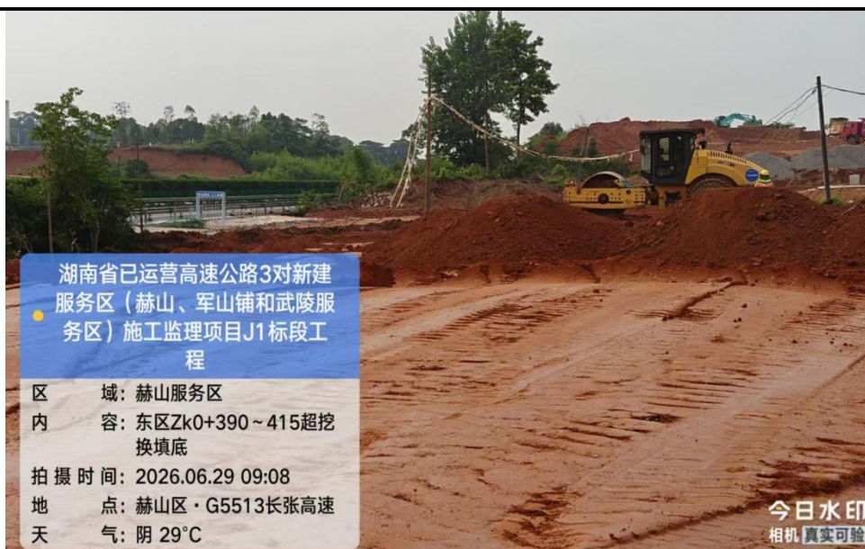
图 3-3 本项目前期场地平整施工现状
