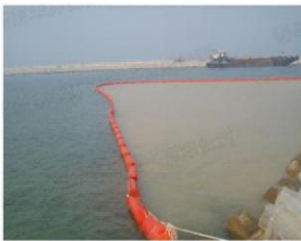
烟台港水域施工、水体防护工程
