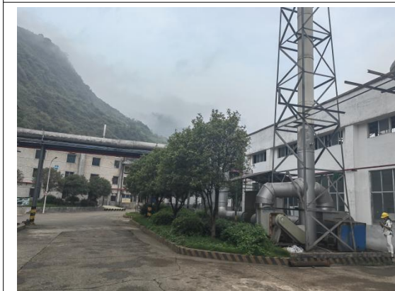
203 车间北侧废气处理设施及 3#废气排气筒
