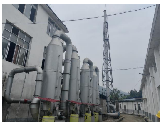
203 车间南侧废气处理设施及 2#废气排气筒
