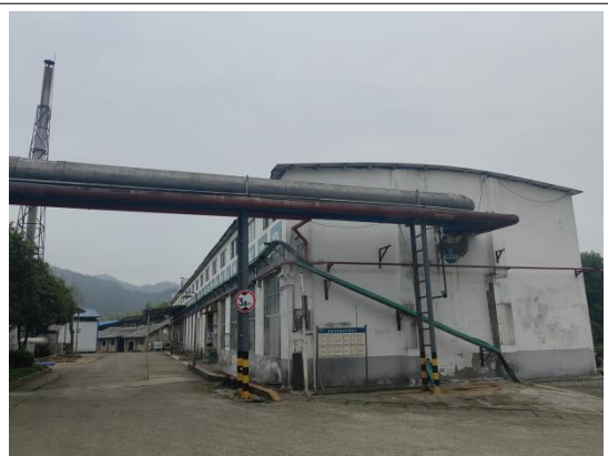
2#烘干房废气处理设施及 4#废气排气筒
