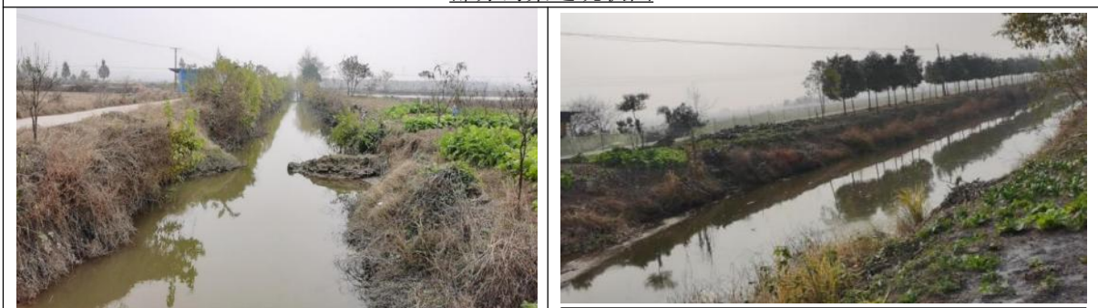
部分渠道岸线现状图
