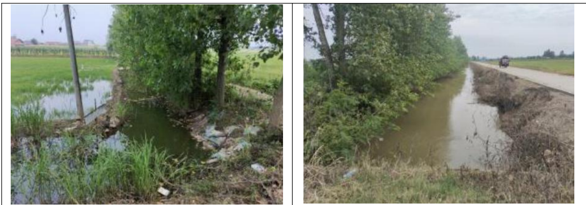
部分沟渠道现状图
