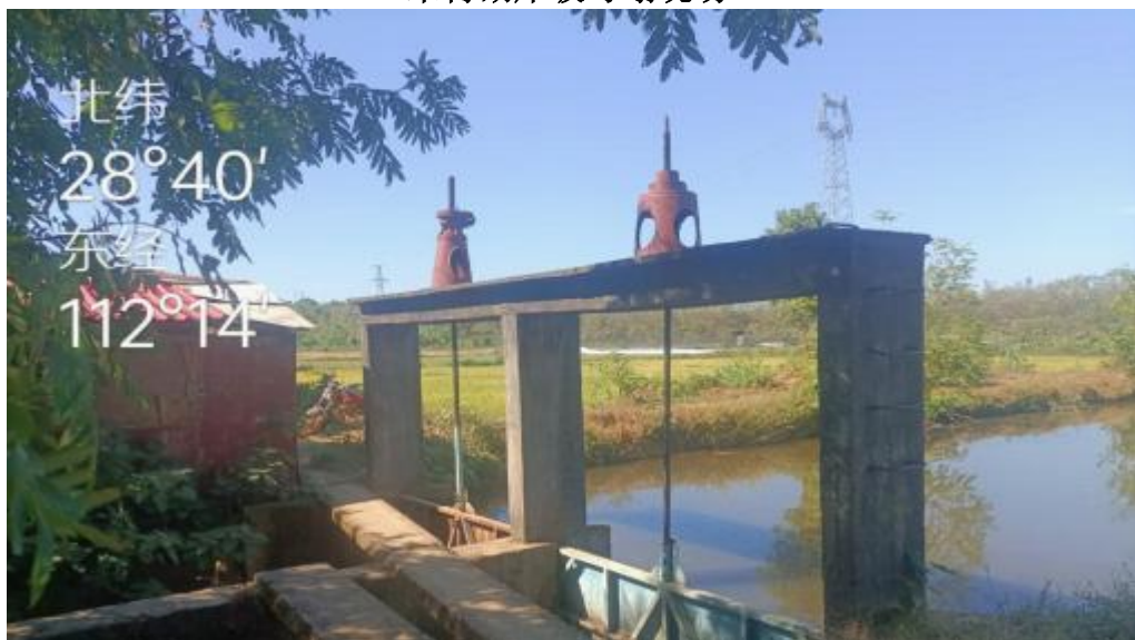
迎风桥控制闸
