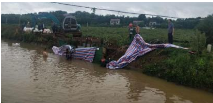
甘溪港小河岸坡水毁
