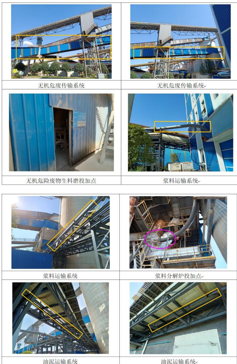
危废运输投加系统现场照片
