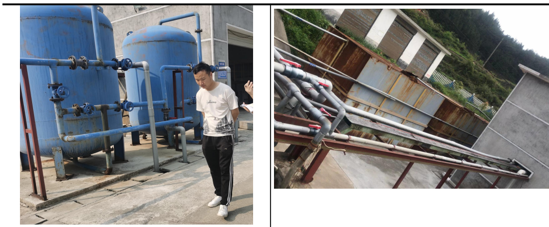
图 5.4-2 现有 污水处理厂现场照片
