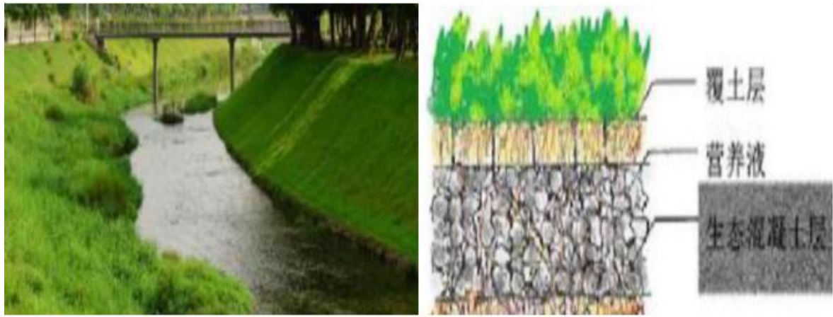
图 3.3-12 生态混凝土堤岸实例
