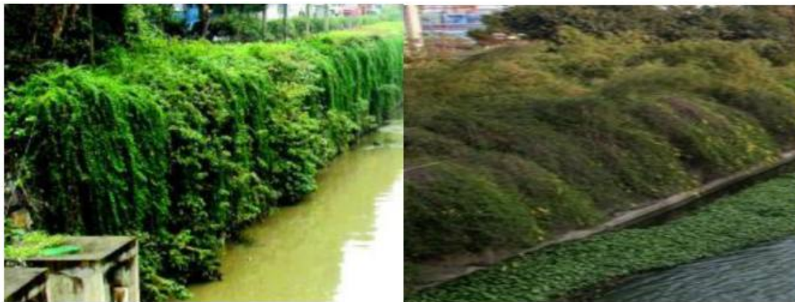
图 3.3-14 藤条倒挂堤岸工程实例
