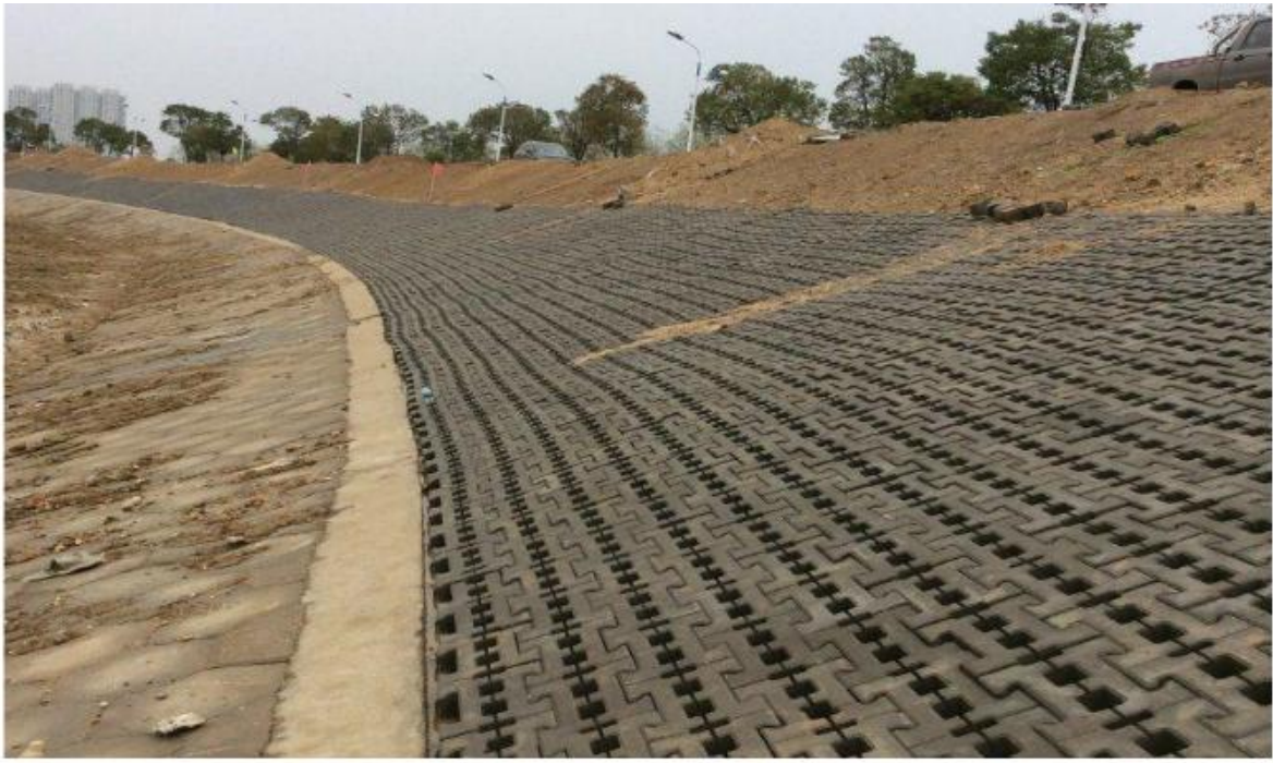
图 3.3-7 生态砖护岸
