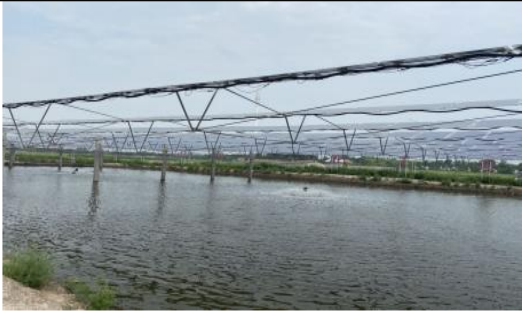
图 2-1 渔光互补柔性支架安装电池阵列
