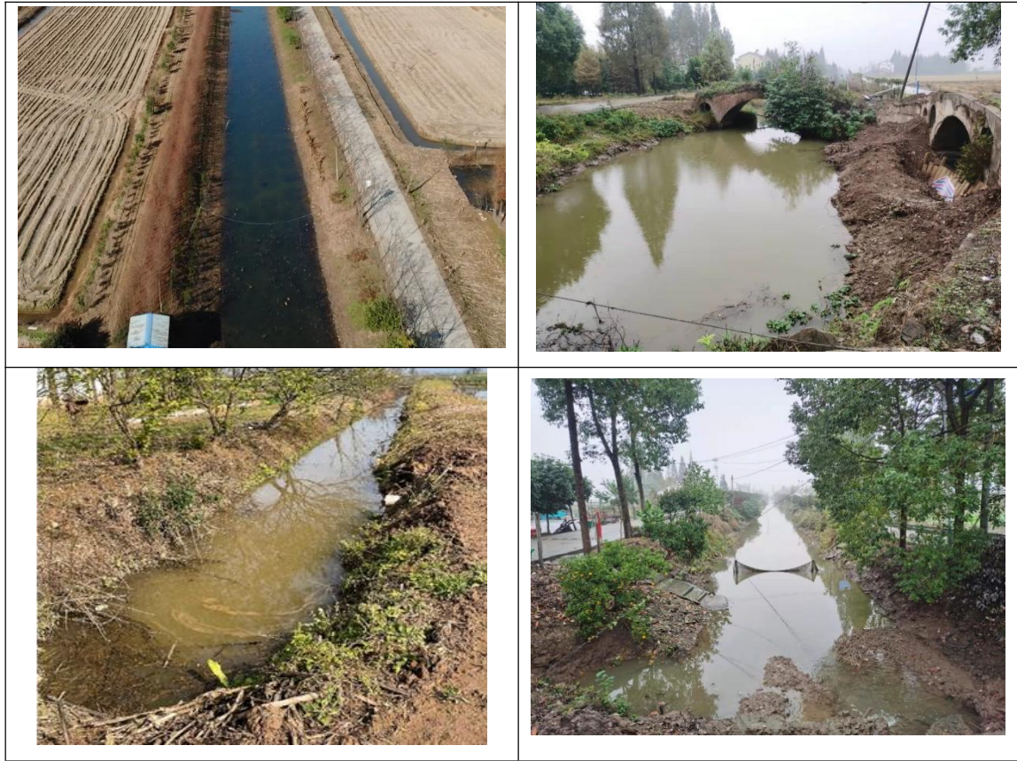
图3.1-4 部分支渠岸坡现状
