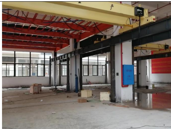
本项目厂房现状 1 楼
