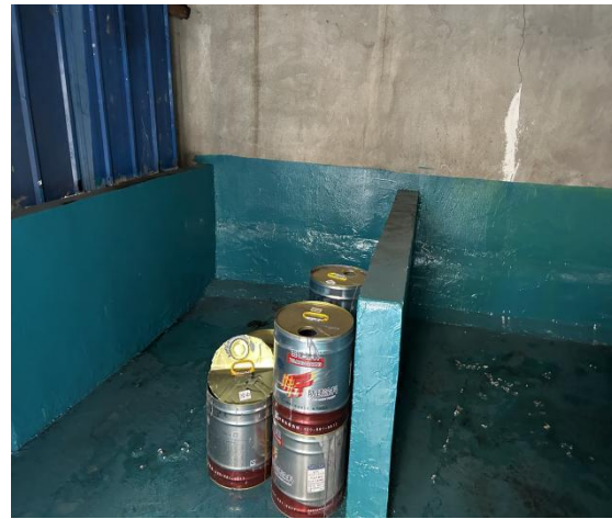
危险废物分区暂存
