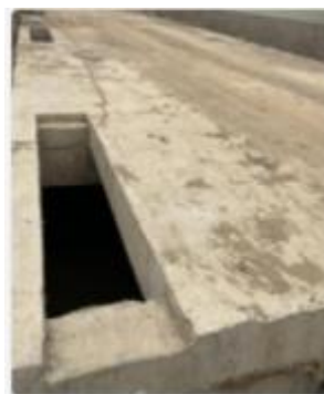
隔油池+三级沉淀池（初期雨水收集池）
