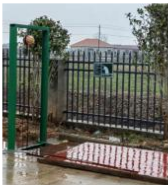
隔油池+三级沉淀池（初期雨水收集池）
