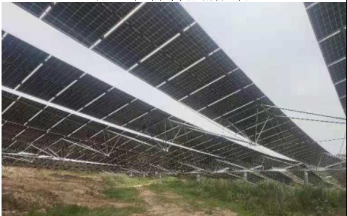
图 2-3 柔性光伏支架实例图
