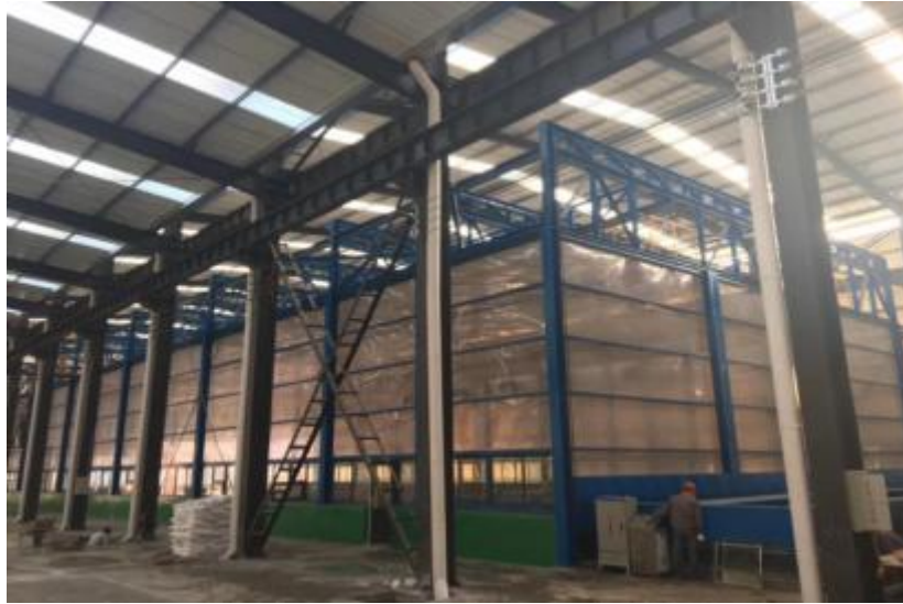
图 7.2-2 同类企业封闭酸洗房实景图
