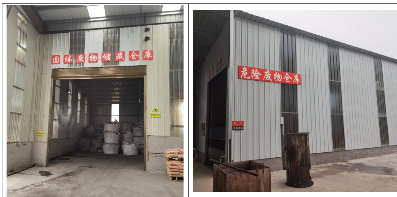
图 2-3 一般固废暂存间和危险废物暂存间现场照片
