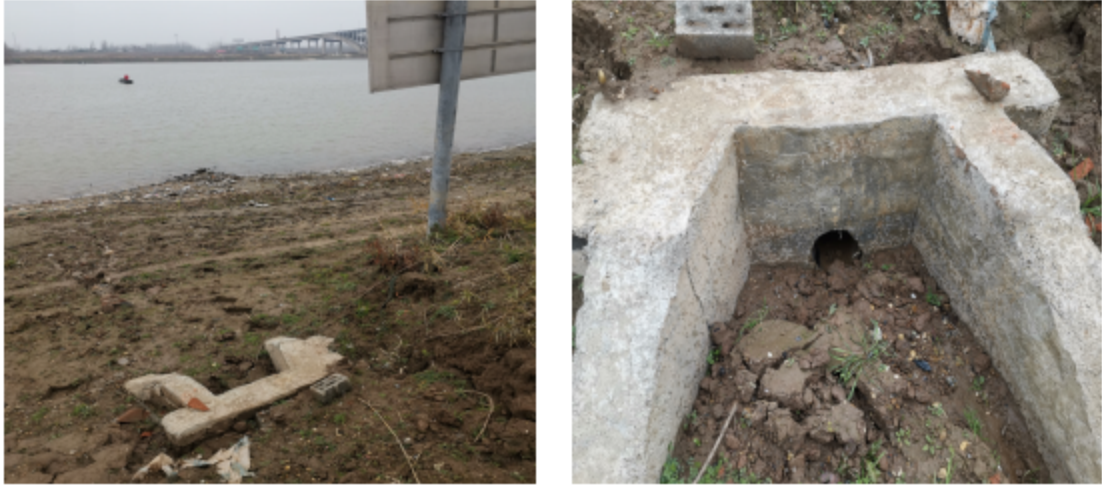
图3.3-2 项目排污口现状
