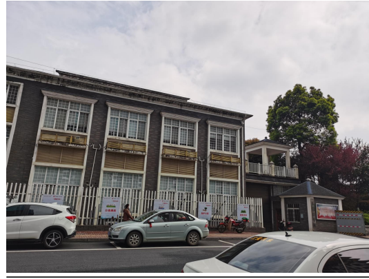
地块南侧紧邻的东门口泵站
