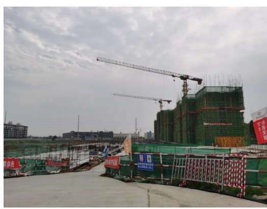
益阳科技创新中心施工场地内情况 1
