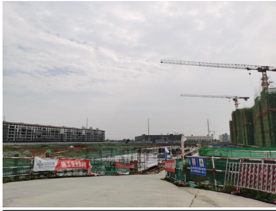
益阳科技创新中心施工场地内情况 2
