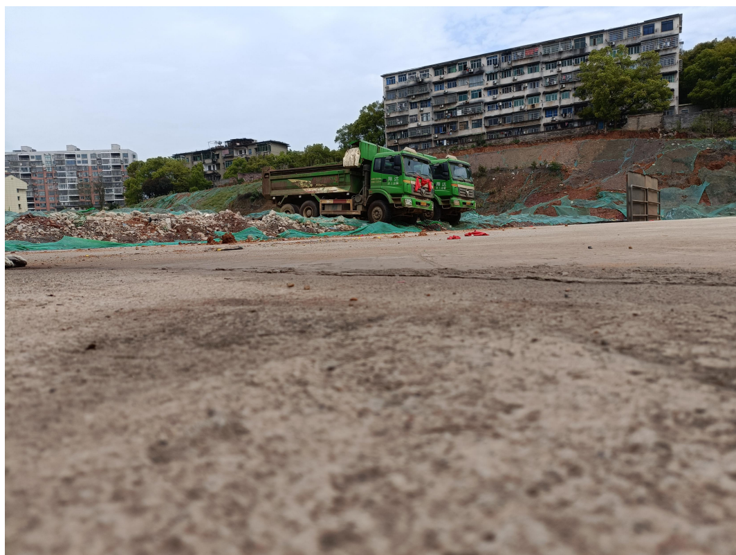
现场踏勘照片
