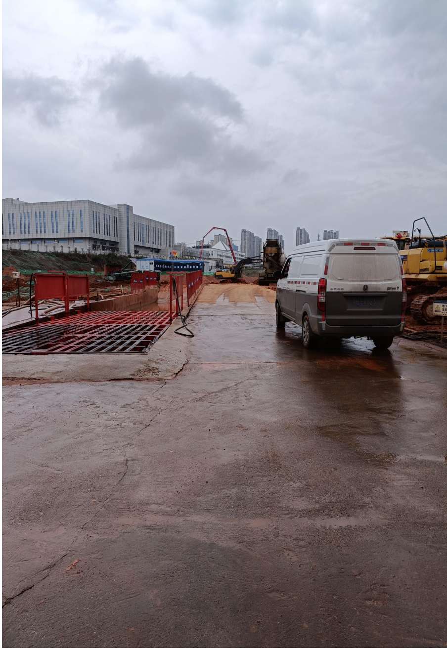
现场调查照片
