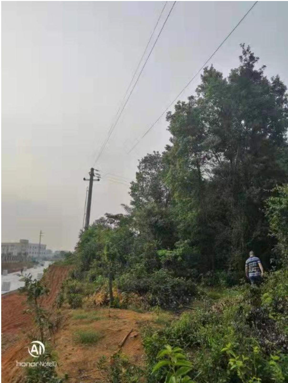
现场踏勘照片
