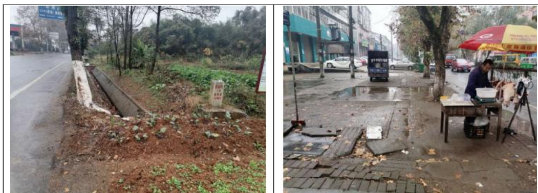
图 2-2 现状道路排水设施
