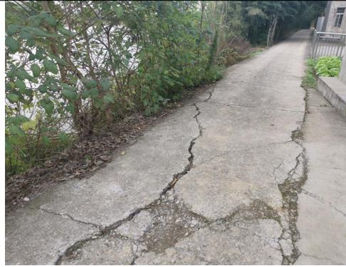
左支流 ZK4+703~ZK4+752 段岸坡崩塌
