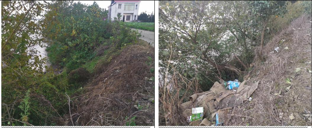
干流 K1+993~K2+059 段右岸坡脚浪蚀严重，形成陡坎，局部岸坡崩塌。
