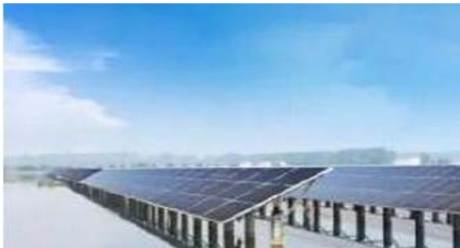
图 2-1 固定式安装方式示意图
