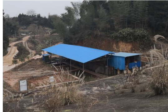
废水处理站(左侧为污泥干化池)
