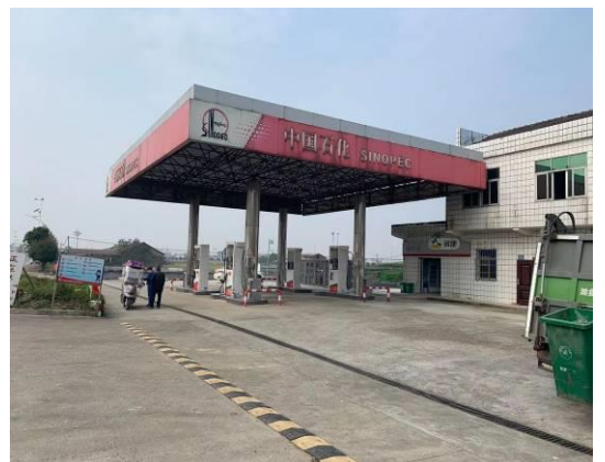
加油站全景及周边集水沟
