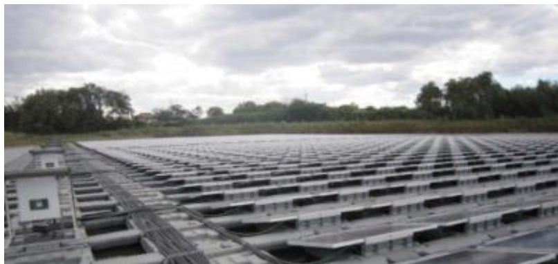
图 1-1 日本全浮箱拼接光伏电站
