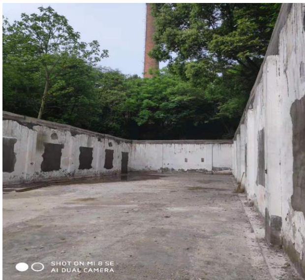
拆解车间建设位置的现状
